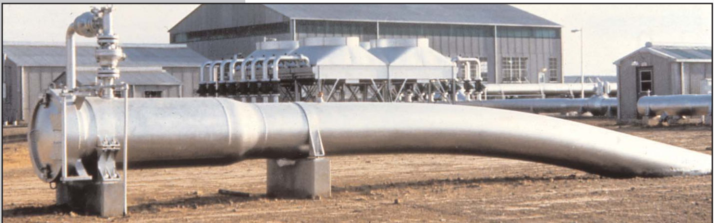
Típico de tapas abisagradas tipo yugo Tube Turns utilizadas con trampas de raspadores.
